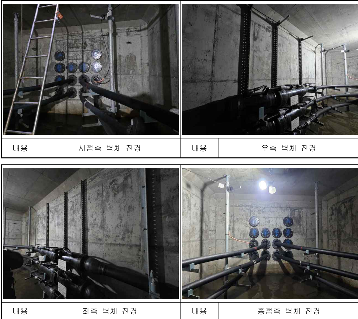
【사진 1.25】 진건~별내#7 전경
