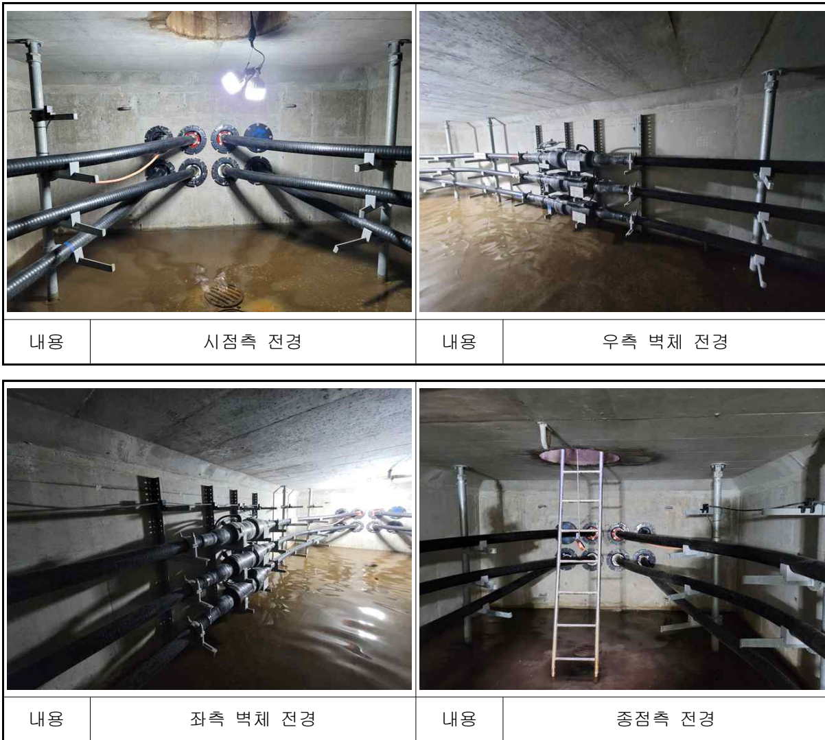
【사진 1.1】 진건~별내#1 전경
