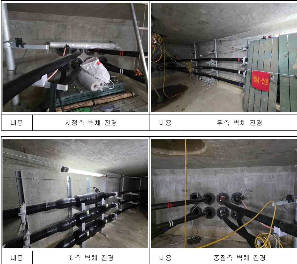
【사진 1.9】 진건~별내#3 전경
