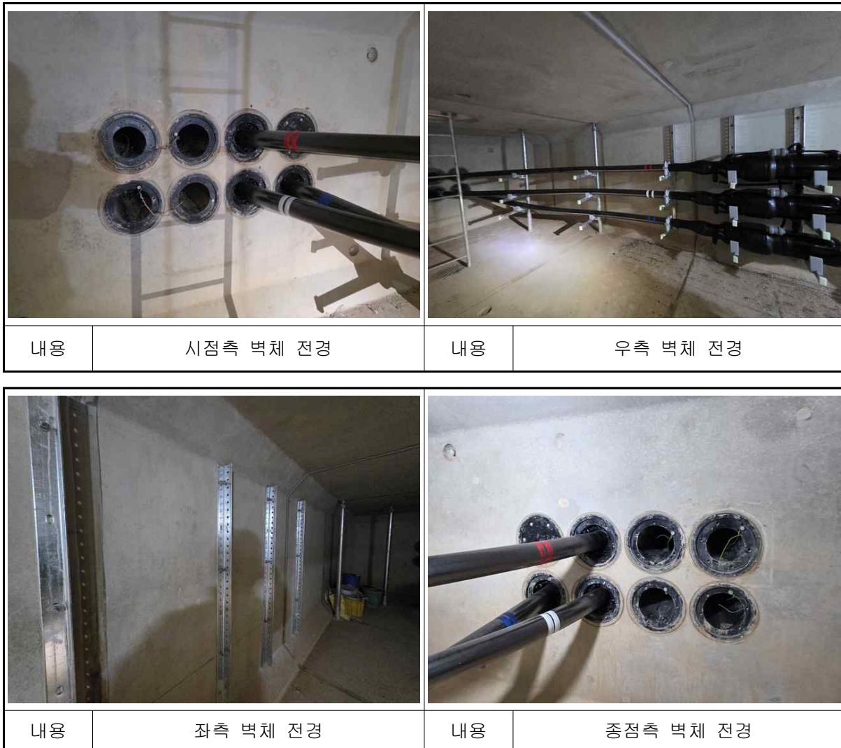
【사진 1.13】 진건~별내#4 전경
