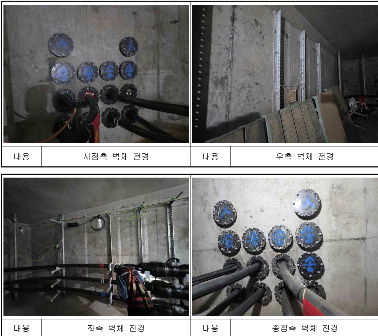
【사진 1.17】 진건~별내#5 전경
