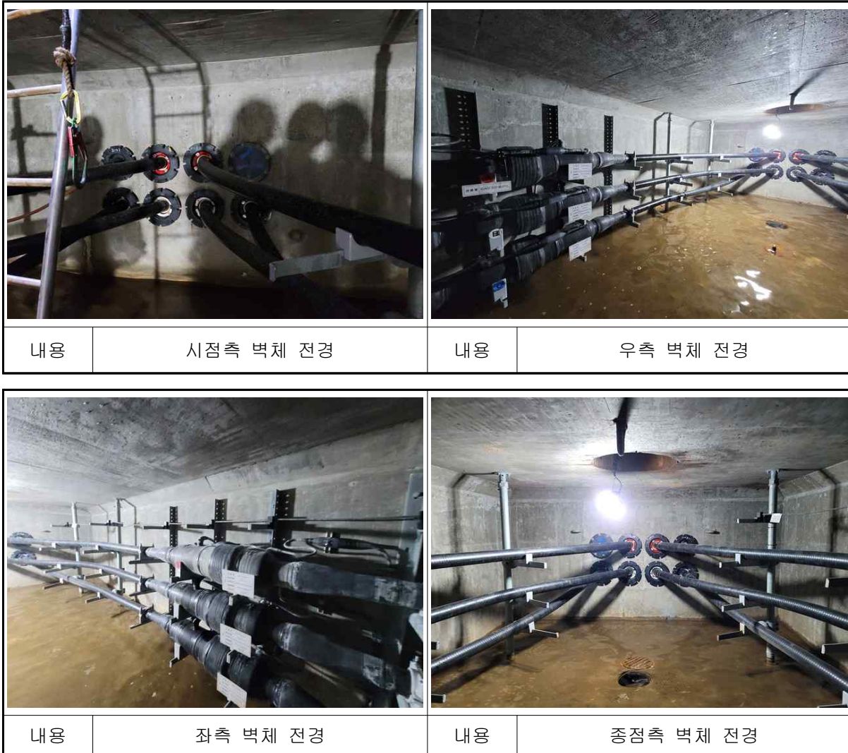
【사진 1.5】 진건~별내#2 전경
