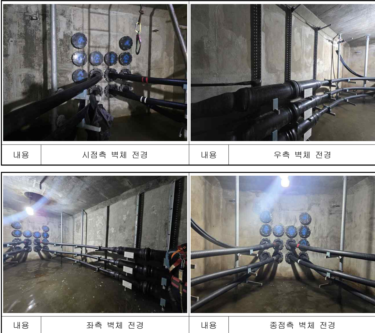
【사진 1.21】 진건~별내#6 전경
